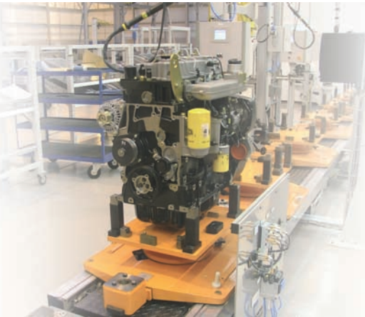
◀ Blick in das Fertigungs- und Montagewerk in Foston bei Derby (Großbritannien). Auf den dort installierten Prüfständen können die Motoren bei allen Drehzahlen geprüft werden, um für höchstmögliche Produktivität und Zuverlässigkeit garantieren zu können.
